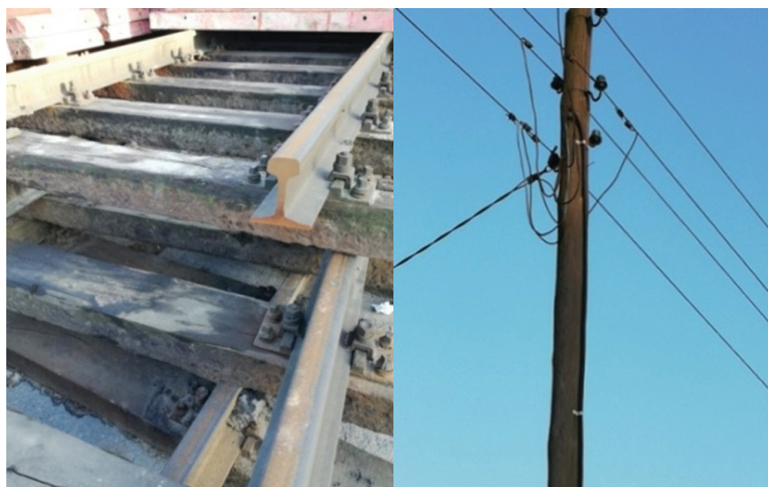
Rys. 1. Elementy drewniane impregnowane kreozotem (fot. B. Ksit)
